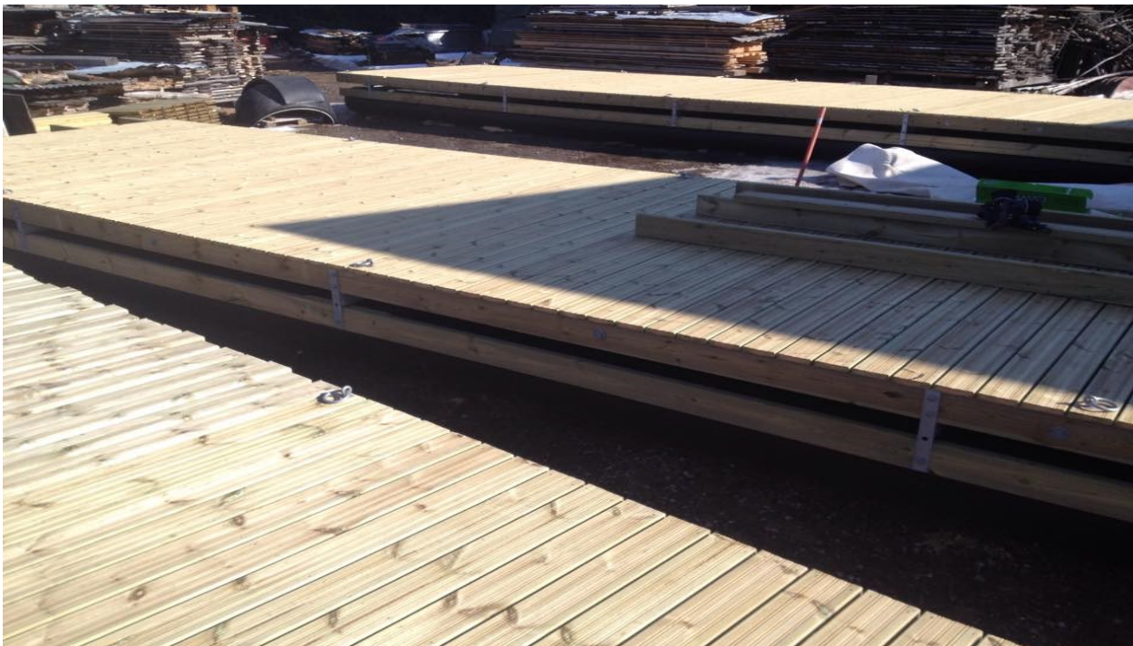
Kuvassa laiturielementit tekeillä Imatralla Laitaatsillan Marinan yhteistyökumppanin tiloissa.
